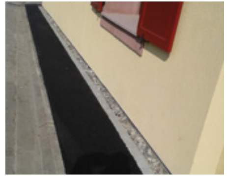
Isolation de soubassement et drainage
