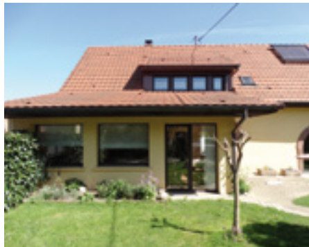
Vue sur la façade Sud
