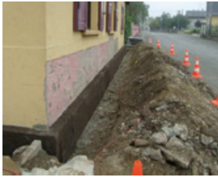
Isolation de soubassement et drainage
