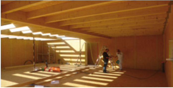
Mise en œuvre de la toiture
