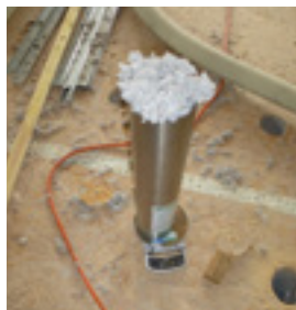
Échantillon de vérification de la densité d'insufflation de la ouate de cellulose
