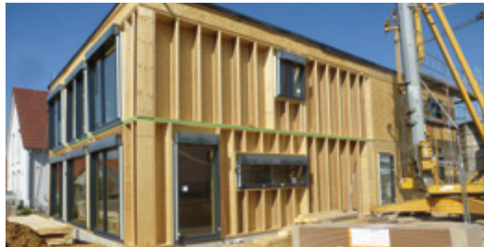
Vue sur l'ossature avant la fermeture des caissons
