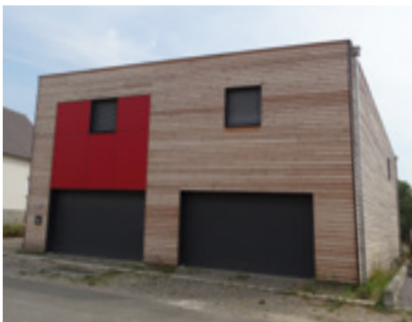
Façade Nord du plancher du 1 er étage
