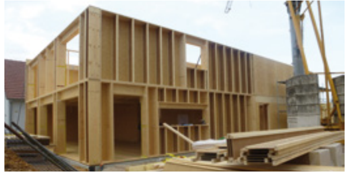
Ossature en bois sur le soubassement en béton
