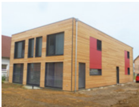
Vue sur les façades Sud et Est
