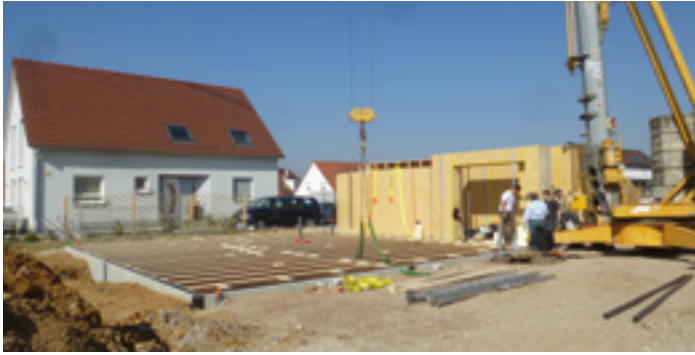
Réalisation du plancher bas
